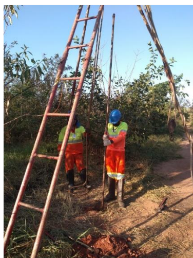
Foto 1 – Sondagem para o poço de monitoramento PM-BDP-13. Mai/2021
