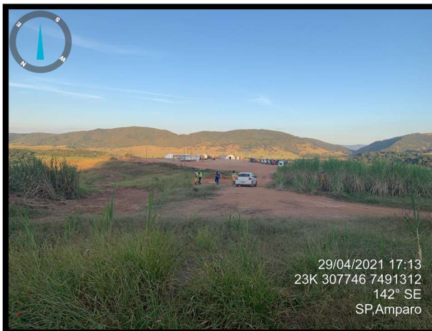
Foto 3 – Local da instalação da EMA no canteiro industrial da Barragem Duas Pontes. Abr./2021
