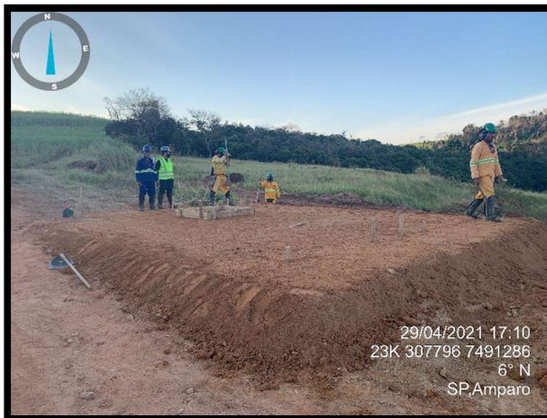
Foto 1 – Preparação do local para instalação da EMA. Abr./2021
