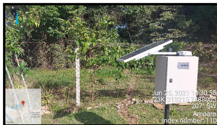
Foto 3 – Estação limnigráfica instalada no PHM. Foto de jun./2021
