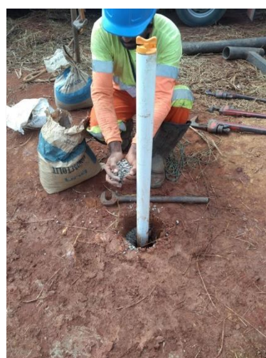
Foto 2 – Instalação do selo de Compactolit (bentonita pelletizada) no poço PM-BDP-02. Mai/2021.
