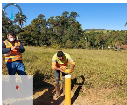
Foto 3 – Poço de monitoramento PM-BDP-01 finalizado.
